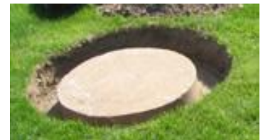
Exemple d'un couvercle bien dégagé
